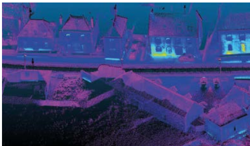
Photo thermique des logements.
